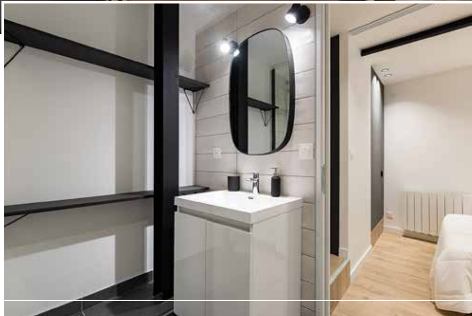
Appartements Lyon (appartement 2) division d'un ancien local commercial en 2 appartements / rénovation / décoration cachet ancien conservé, décoration sobre et moderne
